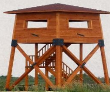
Κατασκευή Παρατηρητηρίου στην περιοχή του Δέλτα Αξιού (Δήμος Δέλτα)
