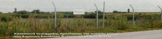
Κατασκευή περιφράξης προστασίας της παλαιάς κώπης στη Δημοτική Κοινότητα Ανατολικού (Δήμος Δέλτα)
