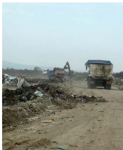
Αποκατάσταση ΧΑΔΑ περιοχής Αιγίνιου
